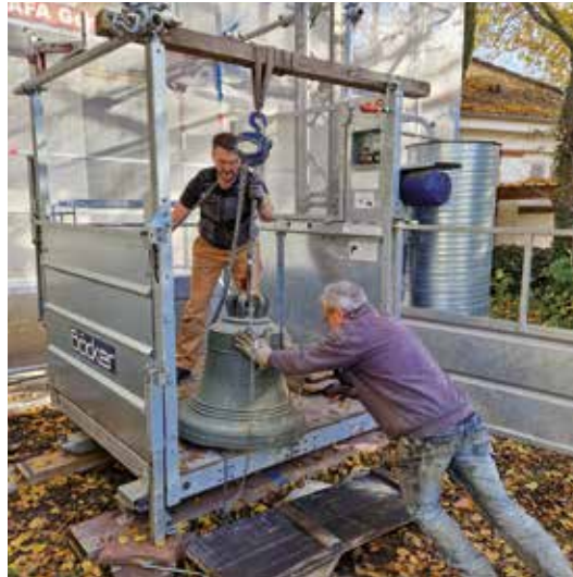
Die Glocke aus der Alten Kirche wird in den Förderkorb des Turmgerüsts verladen.
